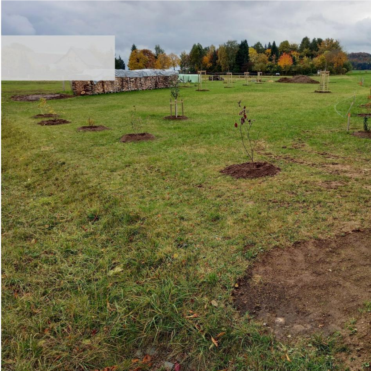
Abbildung 3: Pflanzung der Hochstämme und Hecken Herbst 2023, Im Hintergrund die Erdarbeiten zur Vorbereitung der hinterschütteten Natursteintrockenmauer als Abgrenzung der Streuobstwiese zu den oberhalb anschließenden Grünlandflächen
